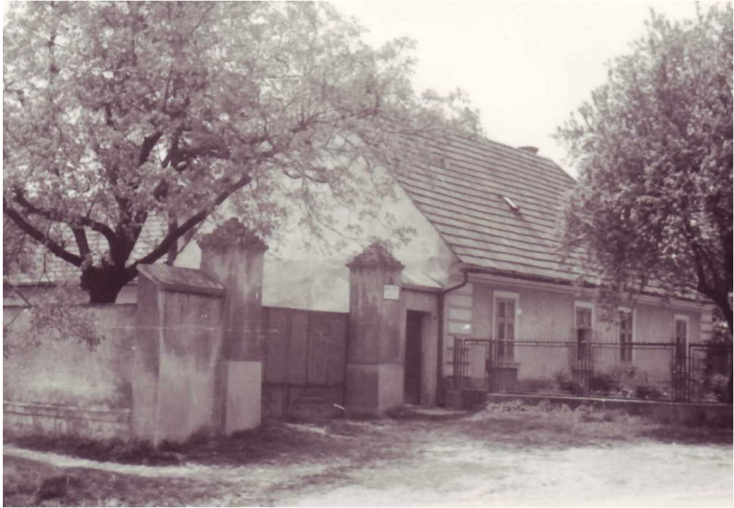
Farskká budova – pohľad uličný
