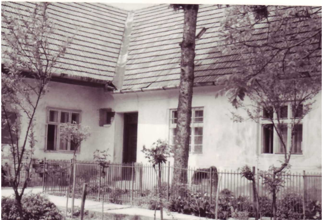
Farská budova – pohľad z dvora
